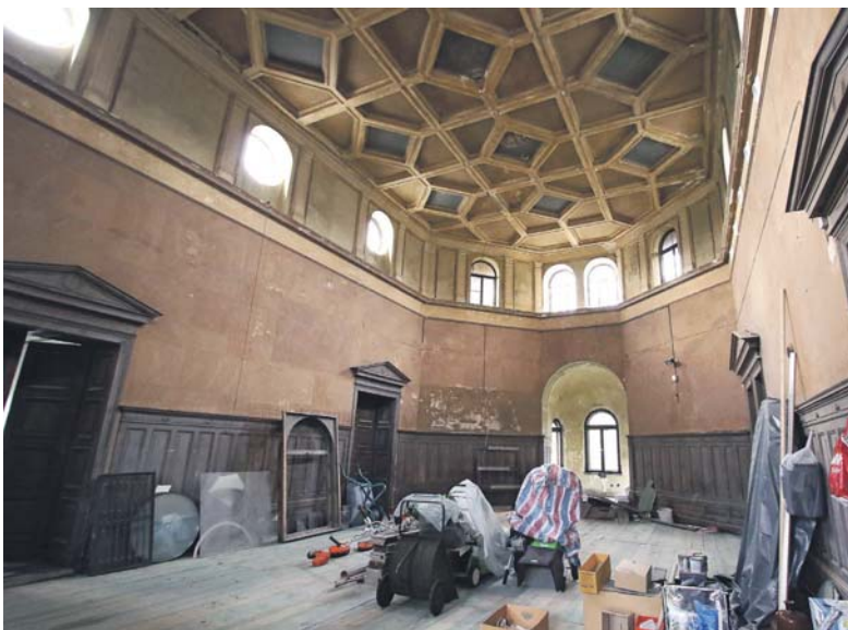
Auch die Trauerhalle wird zurzeit instand gesetzt.
